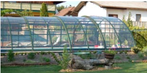
Die Schienen sind verlängert, so dass sich die Anlage ganz zurückfahren lässt.
