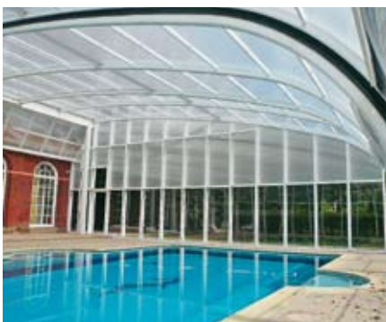
Statische Halle mit zwei schiebbaren Segmenten.
